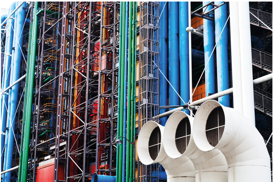
Abb. 2.3: Fassade des Centre Georges Pompidou
