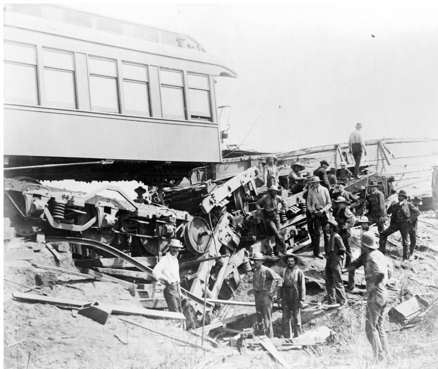
Abb. 3.12: Brückeneinsturz bei Chatsworth mit 82 Toten, 1887
