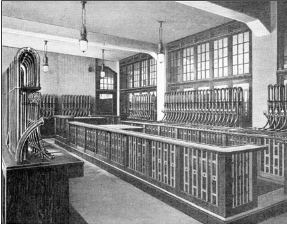
Abb. 8: Hausrohrpostzentrale des Kaufhauses des Westens, Berlin
